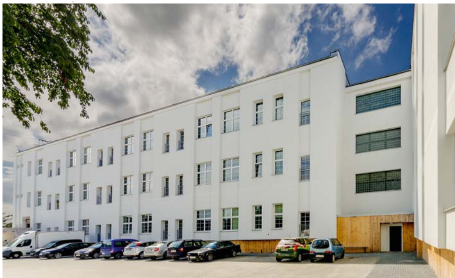
Budynek telekomunikacyjny przekształcony na mieszkalny w Chojnicach
